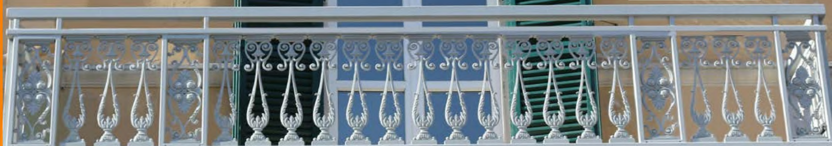
Struttura originale Original structure
